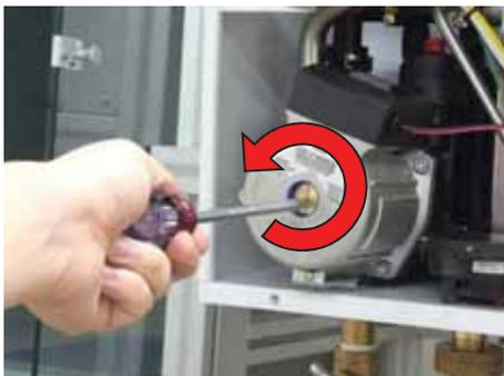
2) Измените режим работы контроллера на «ввод в эксплуатацию» и после этого при помощи плоской отвертки принудительно поверните ось.
