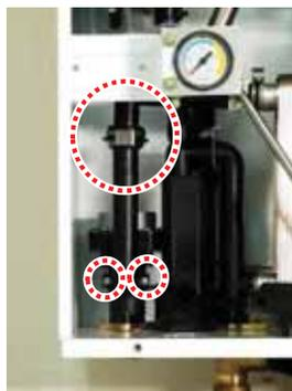
4) Удалите 2 винта из адаптера подачи отопительной воды в нижней части котла.
