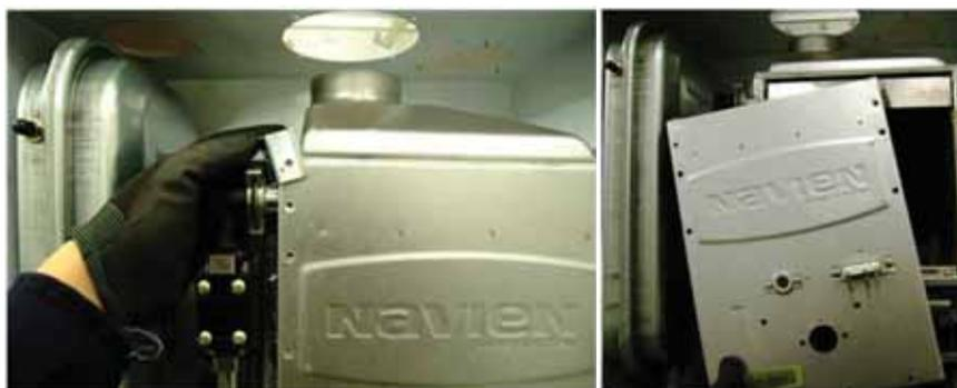
5) Выкрутите 2 винта коллектора с форсунками и замените на коллектор с форсунками нужного размера.
