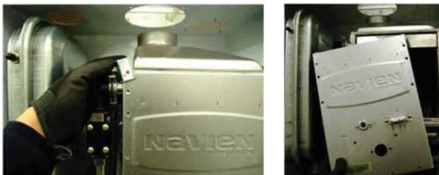
6) Отсоедините коллектор с форсунками, удалив 2 крепежных винта.
