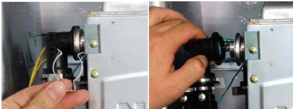
3) Отсоедините 2 трубных зажима сверху и снизу датчика протока ОВ.
