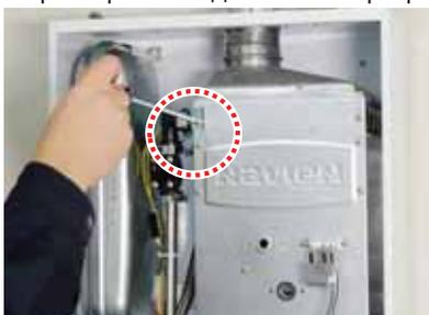
2) Удалите зажим на датчике по перегреву и отсоедините присоединенный к датчику по перегреву коннектор.
