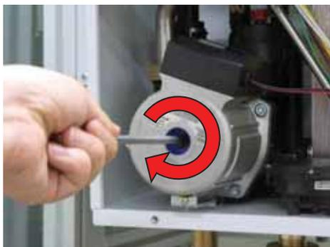
3) Каждый раз в начале запуска насос не включается в работу, а при принудительном повороте оси и нормальной работе насоса показывает неисправность конденсатора.
