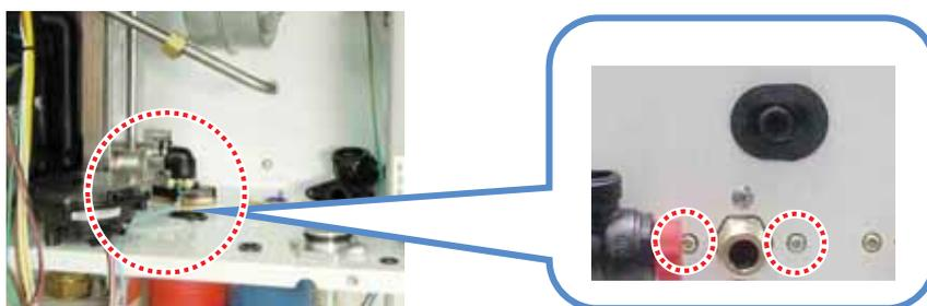
3) Снимите 2 зажима в нижней части теплообменника ГВС и выньте его.
